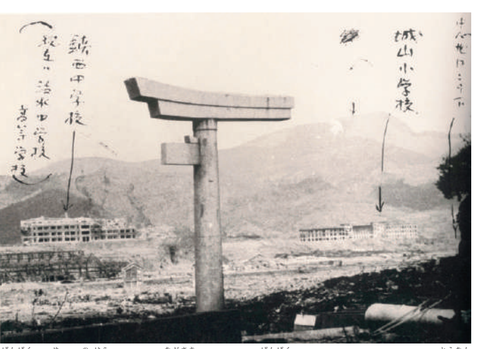
原爆で焼け野原になった長崎のようす。原爆がおとされたところから東南800メートルにある山王神社の二の鳥居は、爆風で柱を1本ふきとばされてしまった。(『日本写真全集4戦争の記録』から)
